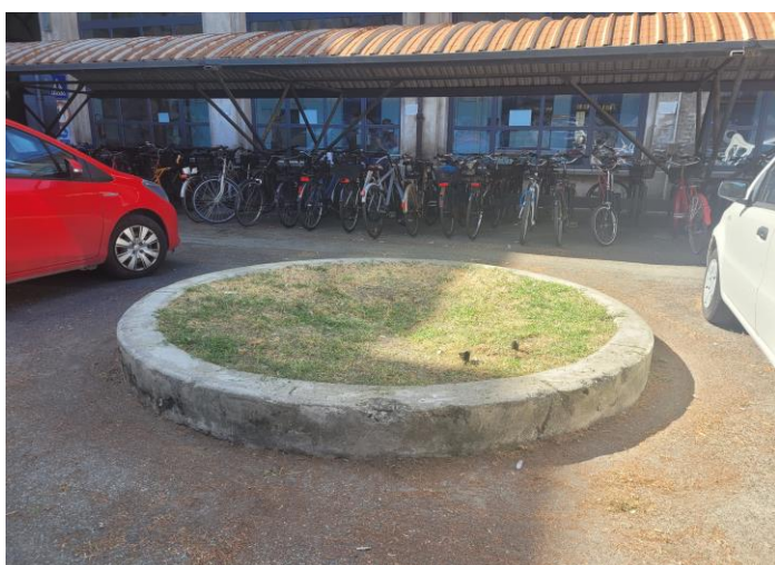
Foto 6 – Aiuola da demolire
